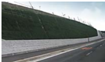
（資料1） 同社製品を用いた施工例 <盛土補強> <河川護岸>
