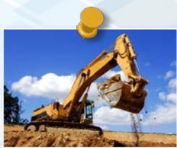
IT建機での自動施工
